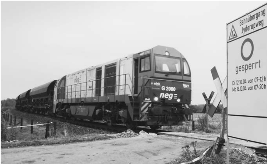
Arbeitszug für die Gleiserneuerung zwischen Husum und Jübek. Foto: Holger Michael
