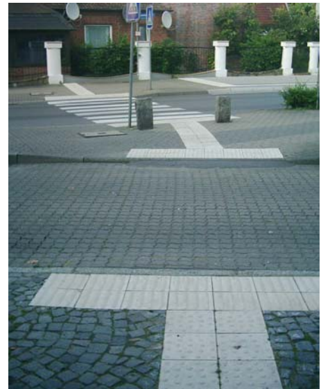
Abb. 1: Abgesenkte Bordsteinkanten und Blindenleitsystem Bahnhofsvorplatz Schleswig
